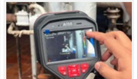
Detección de fuga de gas
