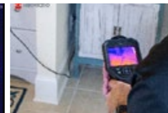
Inspección Suelo Radiante
